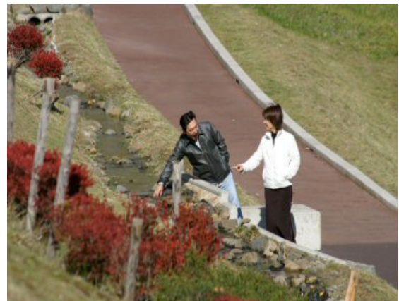
写真-2 通路沿いの腰高の水路
