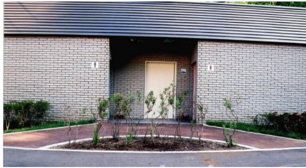
写真-1 改造トイレの進入路
